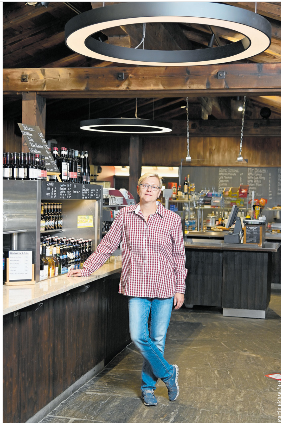
Das 700 Quadratmeter grosse Bergrestaurant Tegia Curnius in Laax setzt auf LED. Der Stromverbrauch für die Beleuchtung sank von 21,2 auf 8,4 Megawattstunden pro Jahr.
